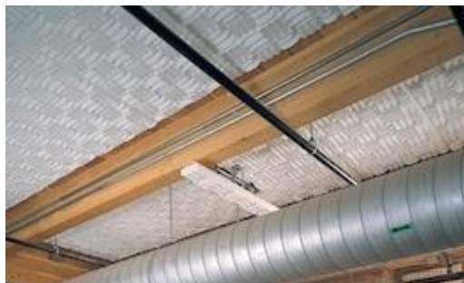
Figura 7. Panel cielorraso de gypsum dispuesto para el techo
