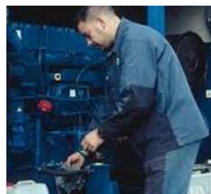
Figura 12. Personal en mantenimiento del generador
