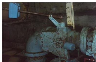
Figura 2. Válvula reguladora de la tasa de filtración actual
