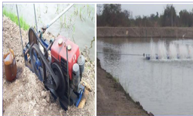
Figura 2. Sistema de aireación con motor diésel
