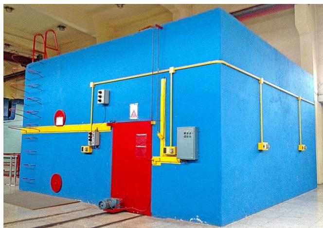
Figura 4.- Cámara de radiación del Irradiador de Cobalto 60. (Fotografía por: Estefanía Montesdeoca)
