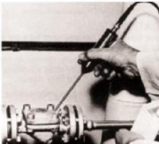
Figura 4. Revisión ultrasónica de trampas de vapor. (Fuente: [8])
