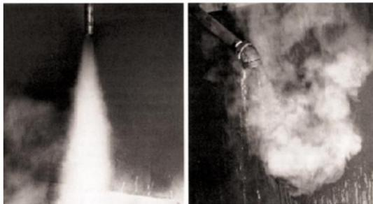
Figura 2. Descarga de trampa de vapor (Fuente:[12])
