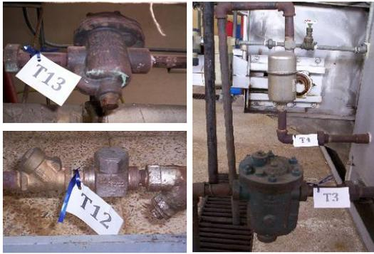
Figura 11. Identificación en sitio de trampas de vapor.
